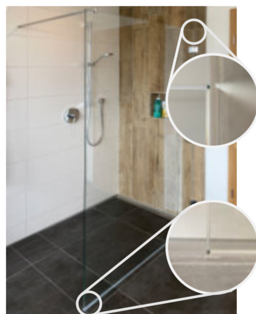
Abb. 3: Exakte Abstände zwischen Glas und Fliese
